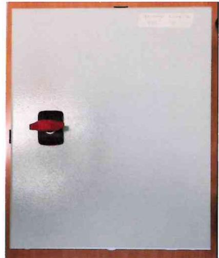
Ce coffret sera protégé par la mise en place d'un disjoncteur installé en tête de tableau divisionnaire (TD Bâtiment) par un disjoncteur 10A Courbe C avec Icc < 20kA Type Schneider iC60N 2P 10A.
