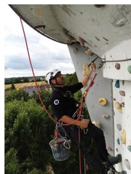
Contrôle des points d'ancrage et traitement des épaufures
